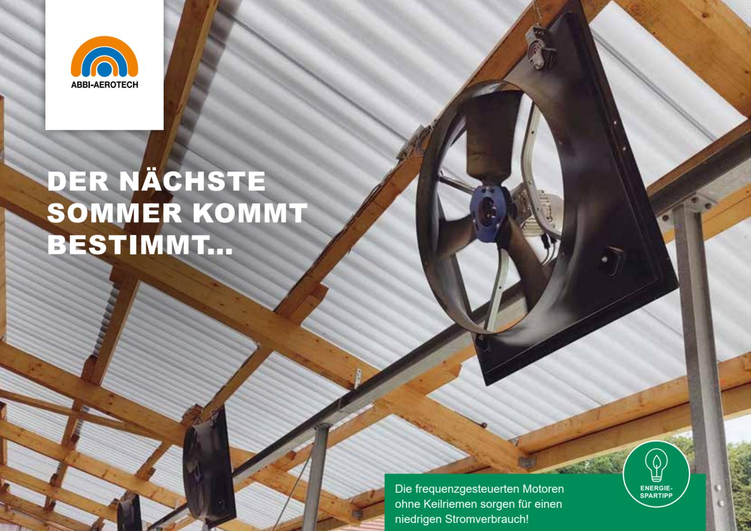
Die frequenzgesteuerten Motoren ohne Keilriemen sorgen für einen niedrigen Stromverbrauch!
